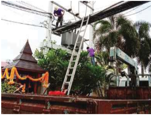
การตรวจสอบและซ่อมบำรุงหม้อแปลงไฟฟ้า
